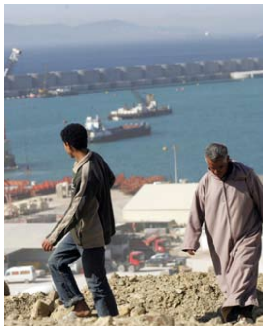
Chantier du complexe portuaire de Tanger-Med
